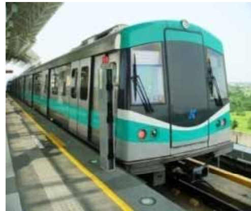
高雄捷運工程
