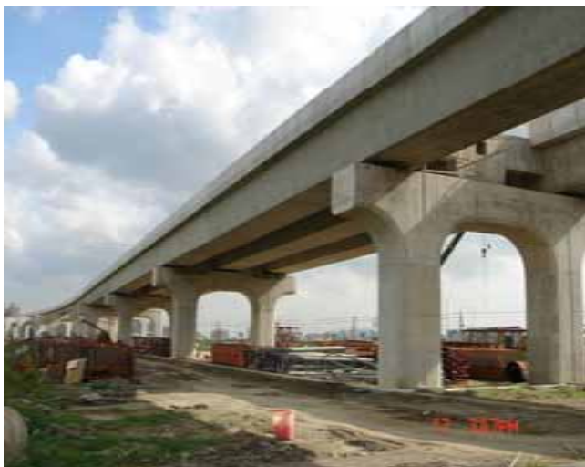
高雄捷運高架工程
