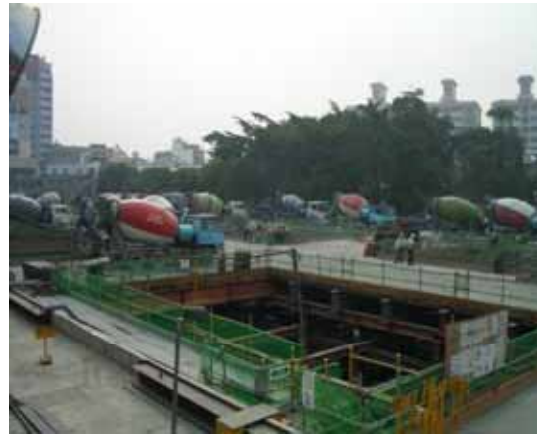
高雄捷運中正路場坍坑回填40,000M 3
