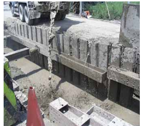
管線回填工程
