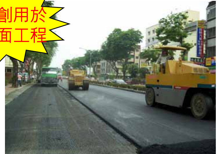
高雄澄清路鋪設中
