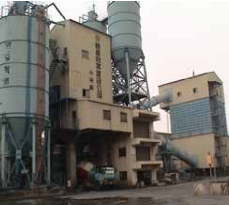
混凝土廠 (客戶)
