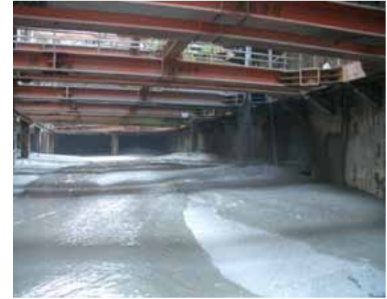
高雄捷運中正路場坍坑回填40,000M 3
