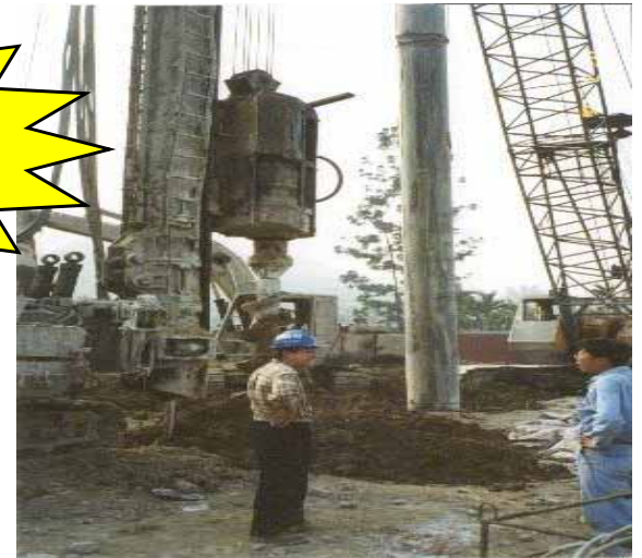
植入樁灌漿工程
