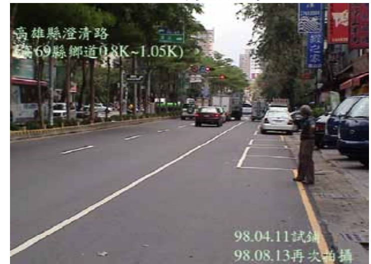
高雄澄清路鋪設後
