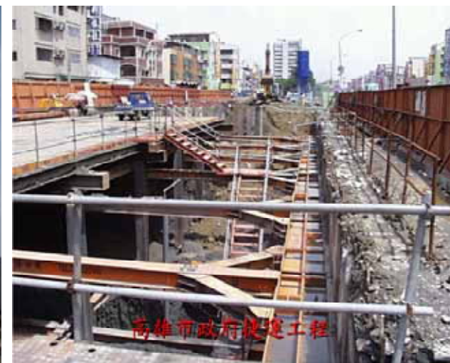
高雄捷運地下工程
