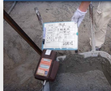
混凝土氯離子檢測
