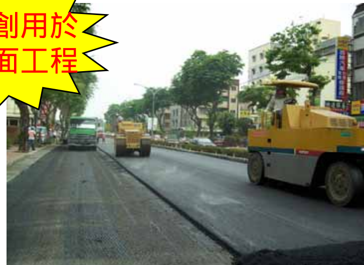
高雄澄清路鋪設中
