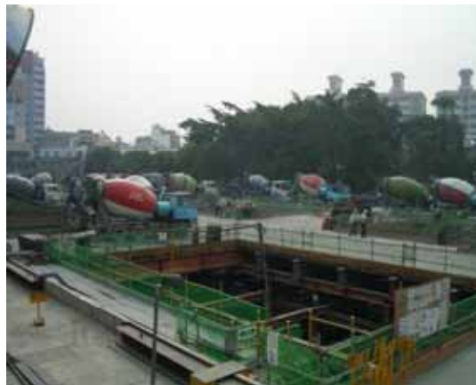
高雄捷運中正路塌坍坑回填40,000M 3
