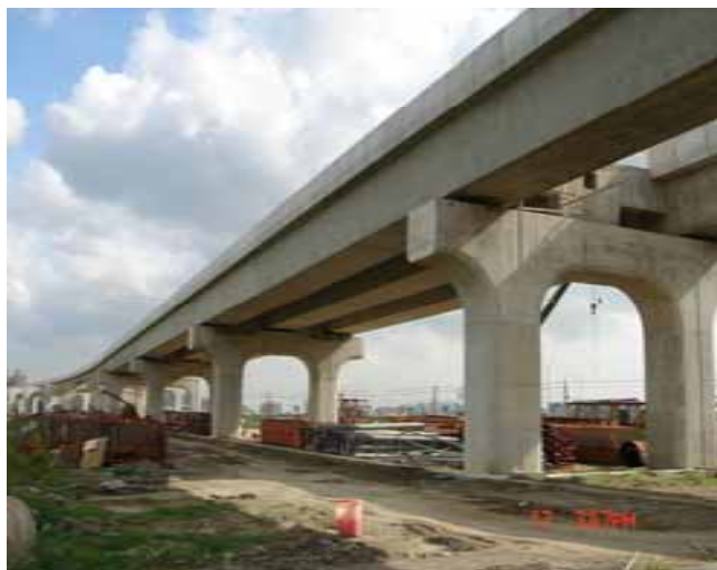
高雄捷運高架工程
