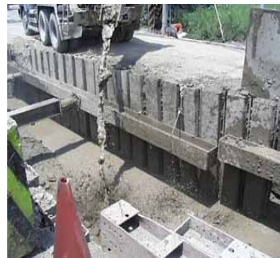
管線回填工程
