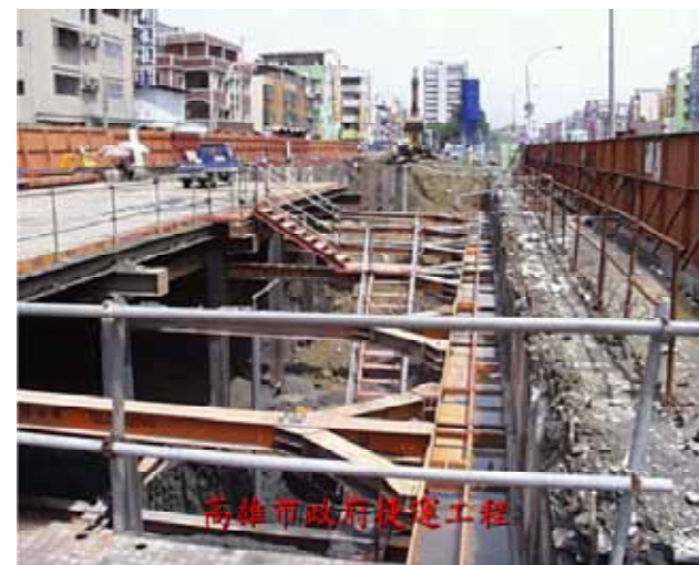
高雄捷運地下工程
