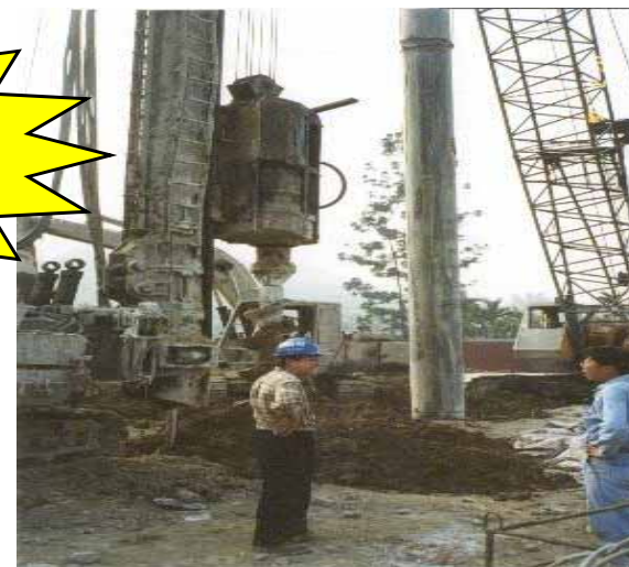
植入樁灌漿工程
