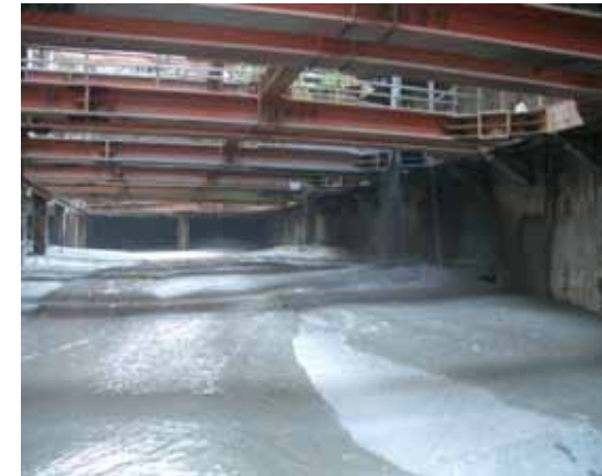
高雄捷運中正路塌坍坑回填40,000M 3
